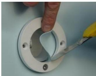
Découpez ensuite le liner à l'intérieur de la bride blanche et continuez à monter le niveau d'eau jusqu'à la partie inférieure de la pièce à sceller suivante.
